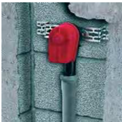
Montage sur cloison : Lavabo, siphon
